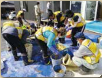
泥だし作業の様子
