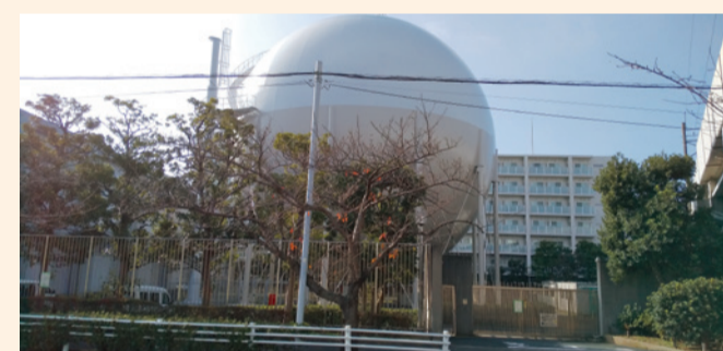
巨大なガス貯蔵タンク
